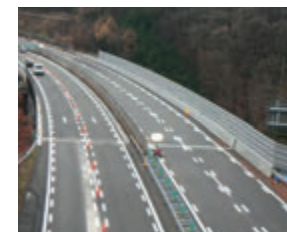
床版取替完了後
