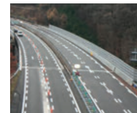
床版取替完了後
