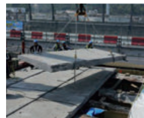
老朽化した床版の撤去
