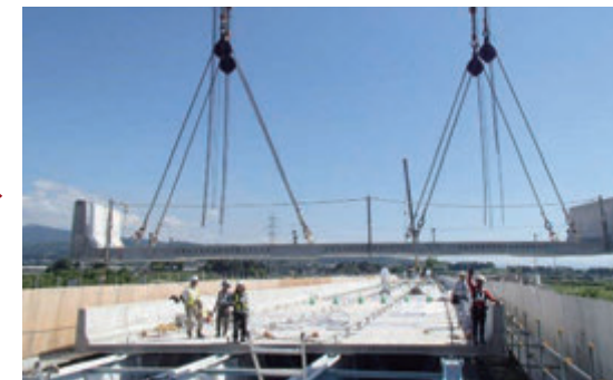
プレキャストコンクリート床版の施工状況
